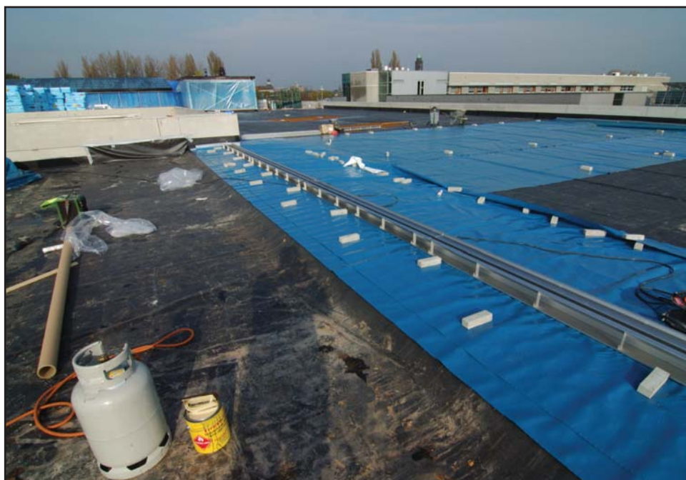
De voorbereidingen zijn getroffen voor de noodzakelijke dilatatieprofielen. De dampremmer met isolatie en nooddakbedekking zijn reeds aangebracht. Foto: Royal Haskoning
