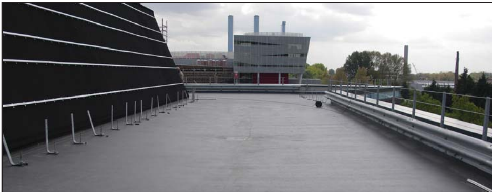
Het duurzame DPS-parkeerdekstelsysteem vormde de laatste laag. Foto: Triflex
