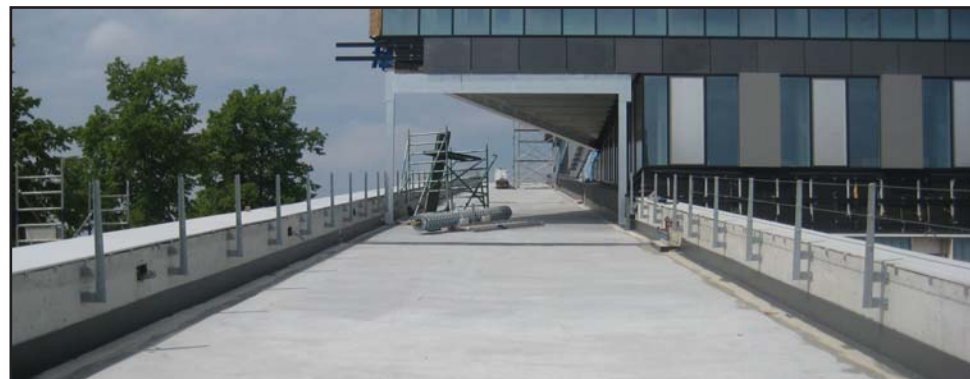
De hellingbaan is voorzien van een betonlaag. Foto: Triflex
